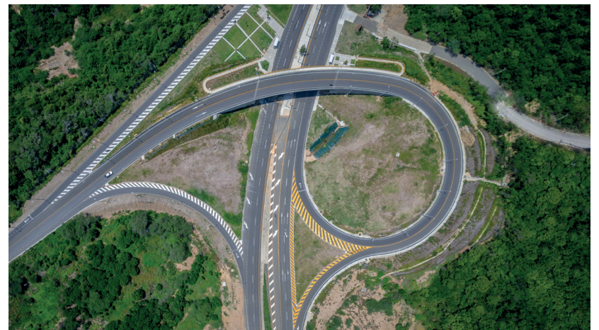
Puente de Puerto Colombia - Constructora: Concesión Costera S.A.S.
